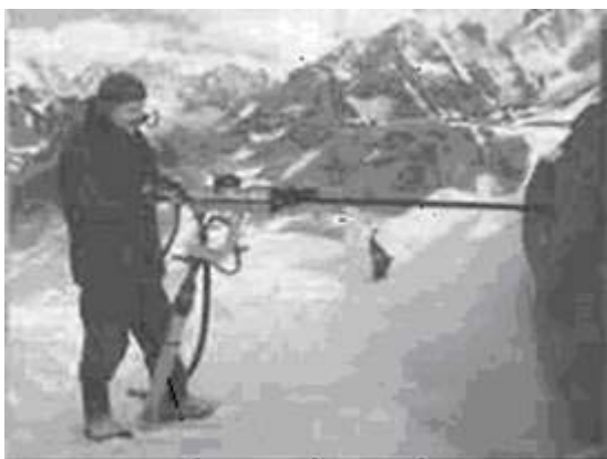
Рис. 1.4. Бурение переносным перфоратором на пневматической поддержке горизонтальных шпуров
