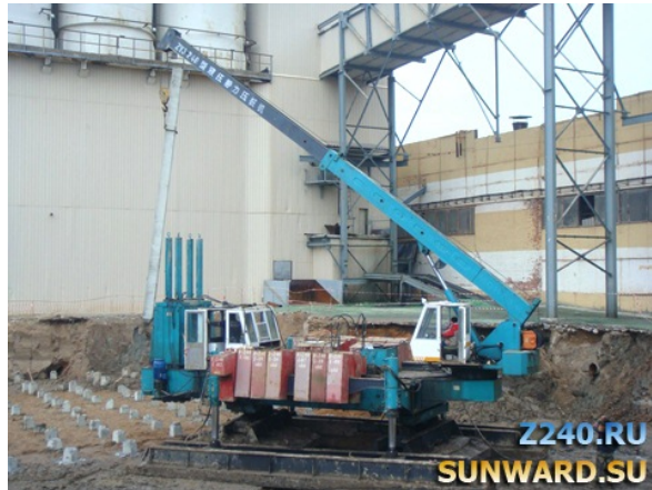
Рис. 8.12. Общий вид машины Z240 Sunward для вдавливания свай с усилием 240 т.
